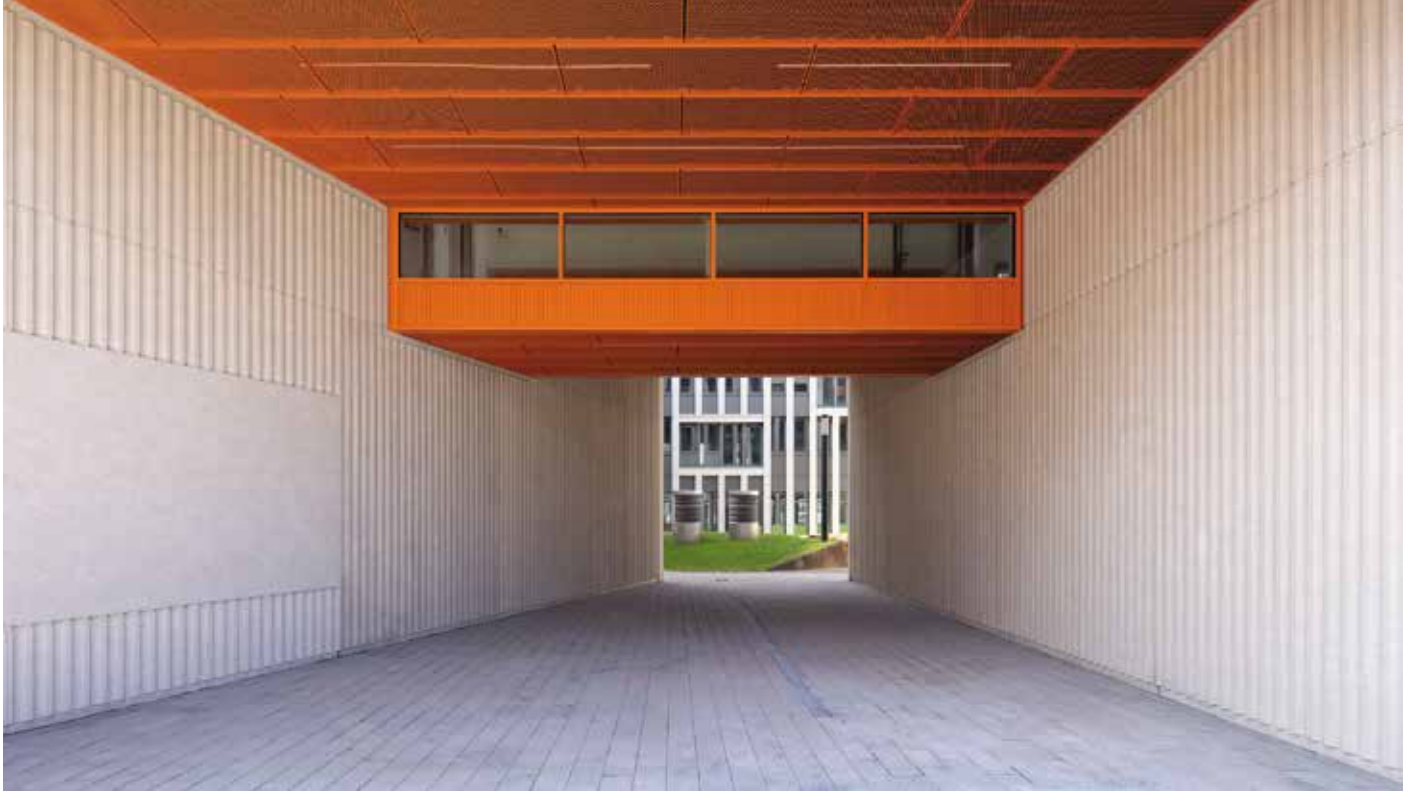
Abb. 1 (Bild oben) Die zweigeschossige Durchfahrt in den Innenhof
