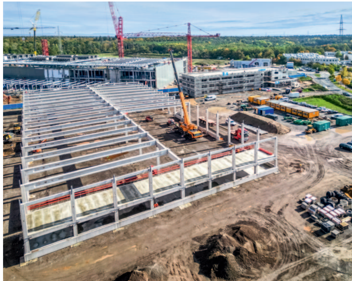
Gut erkennbar: die rechtwinklige Anordnung von Bürogebäude und der Montagehalle im Vordergrund
