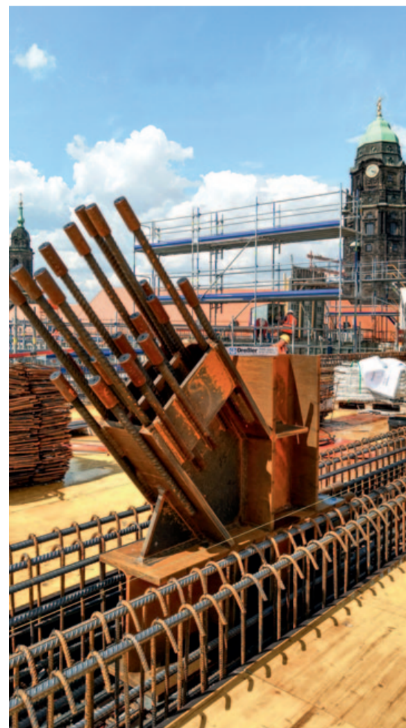
Einbauteil am Untergurt des Fachwerkträgers als verbindendes Element
