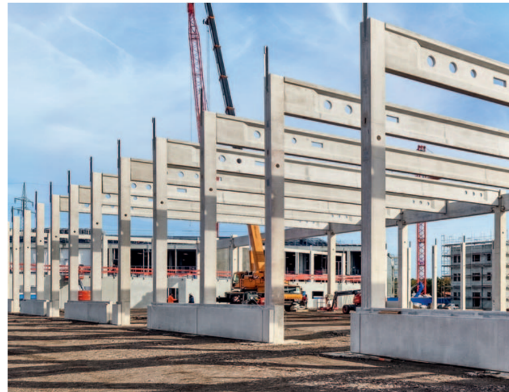
Die Stahlbetondachbinder der Montagehalle werden montiert
