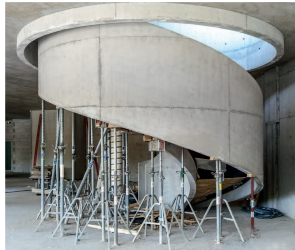
„Schalungskunst in Perfektion“ – die gewendelte Brüstung mit dem dazwischenliegenden Treppenlauf
