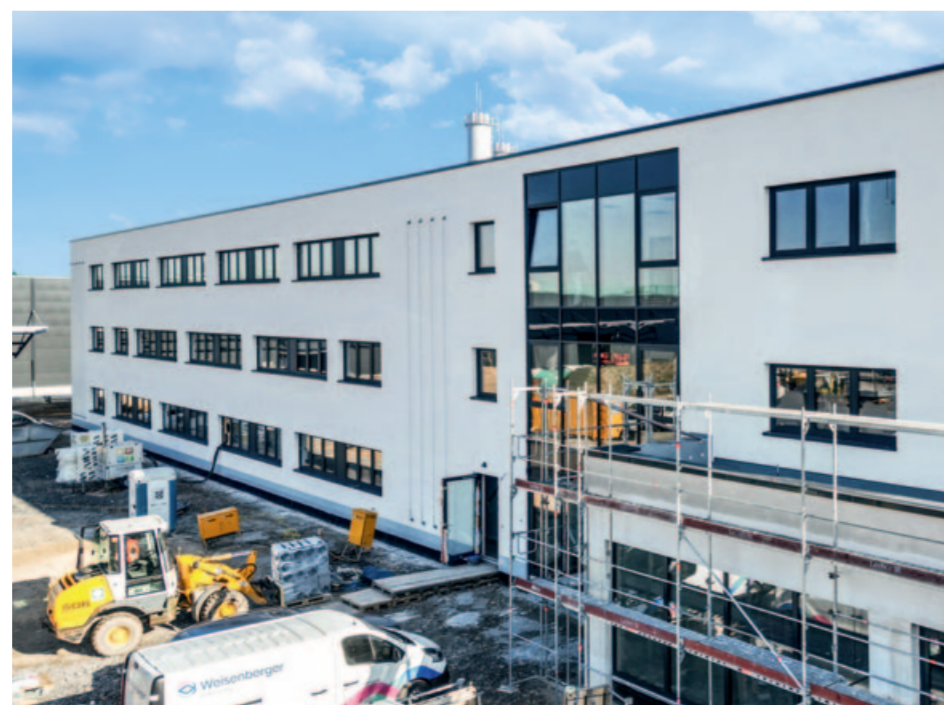
Baufortschritt am Bürogebäude, das bereits so konzipiert wurde, dass eine zukünftige Aufstockung problemlos möglich ist
