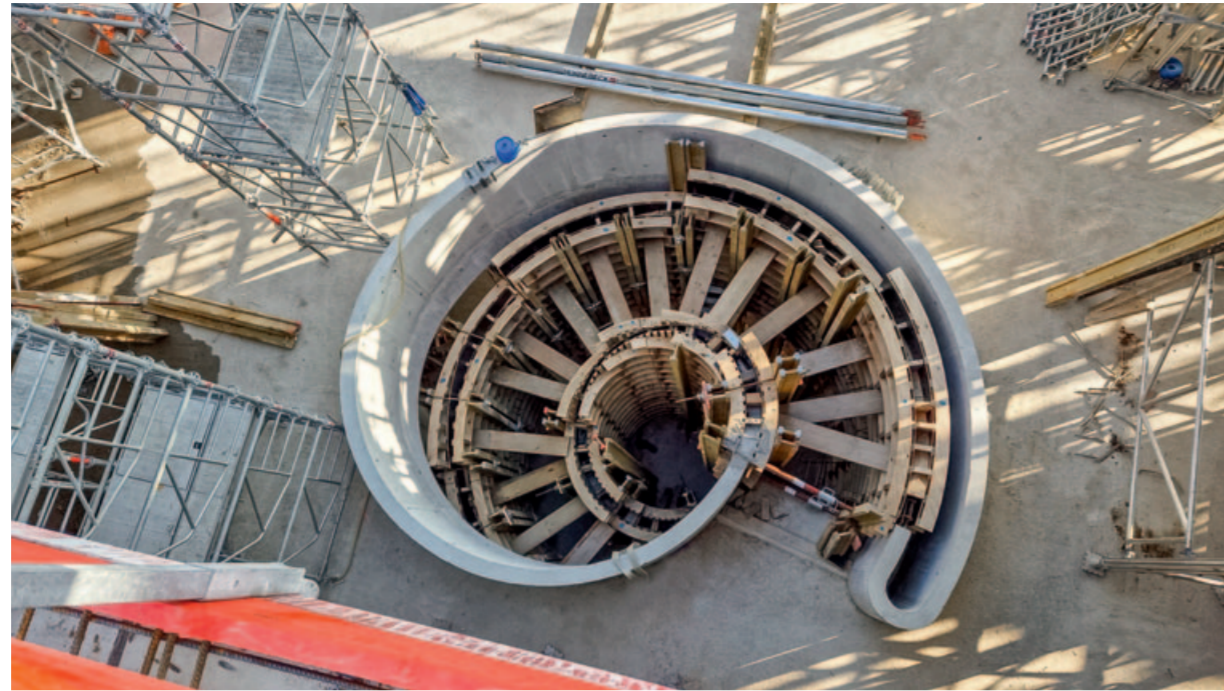
Präzision in jeder Phase: Die Betonage der Seitenwangen wird vorbereitet
