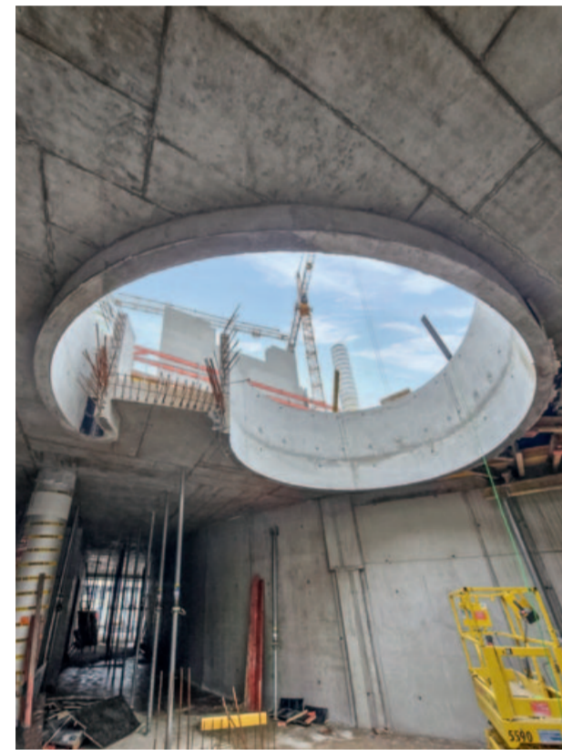
„Allem Anfang wohnt ein Zauber inne“: Die Treppenöffnung mit Brüstung nimmt Formen an
