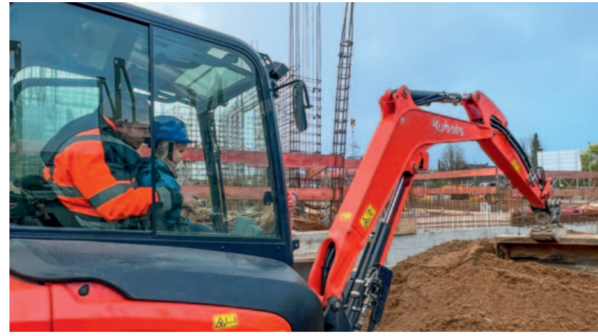
Es wird eifrig gebaggert ...
