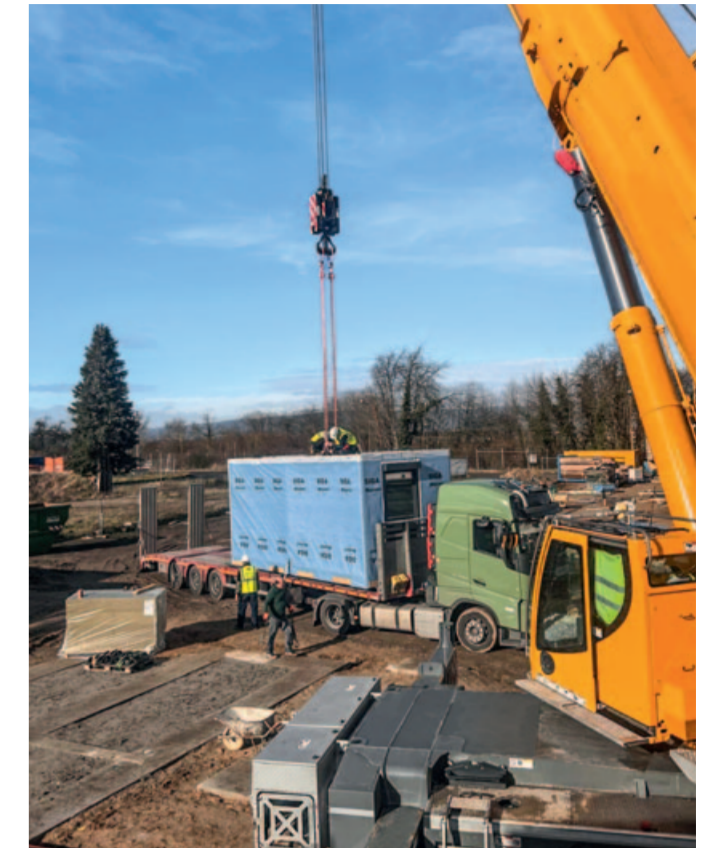
Prinzip Baukasten: „Anschlagen“ eines vorgefertigten Moduls
