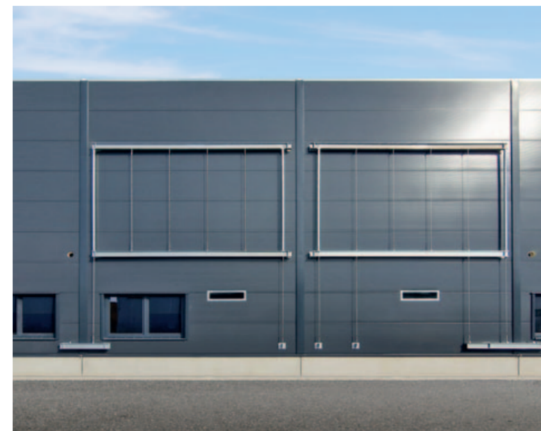
Probemontage der Stahlunterkonstruktion für die Fassadenbegrünung der Montagehalle
