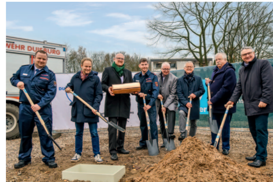
Bei der Grundsteinlegung für ihren Löschzug packten sogar die Mitarbeiter der Feuerwehr, Stadt und Politik mit an – ein starkes Zeichen und ein gutes Omen für die erfolgreiche Realisierung dieses wichtigen Projekts
