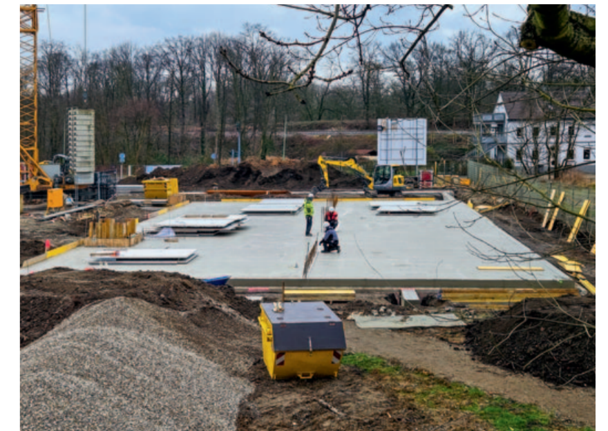
Klassiker auf der Baustelle: Betonage der Bodenplatten in Walsum
