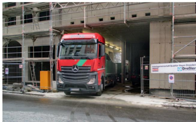
Um diese Durchfahrt zu ermöglichen, musste die Tiefgarage mit Hunderten Balken abgestützt werden
