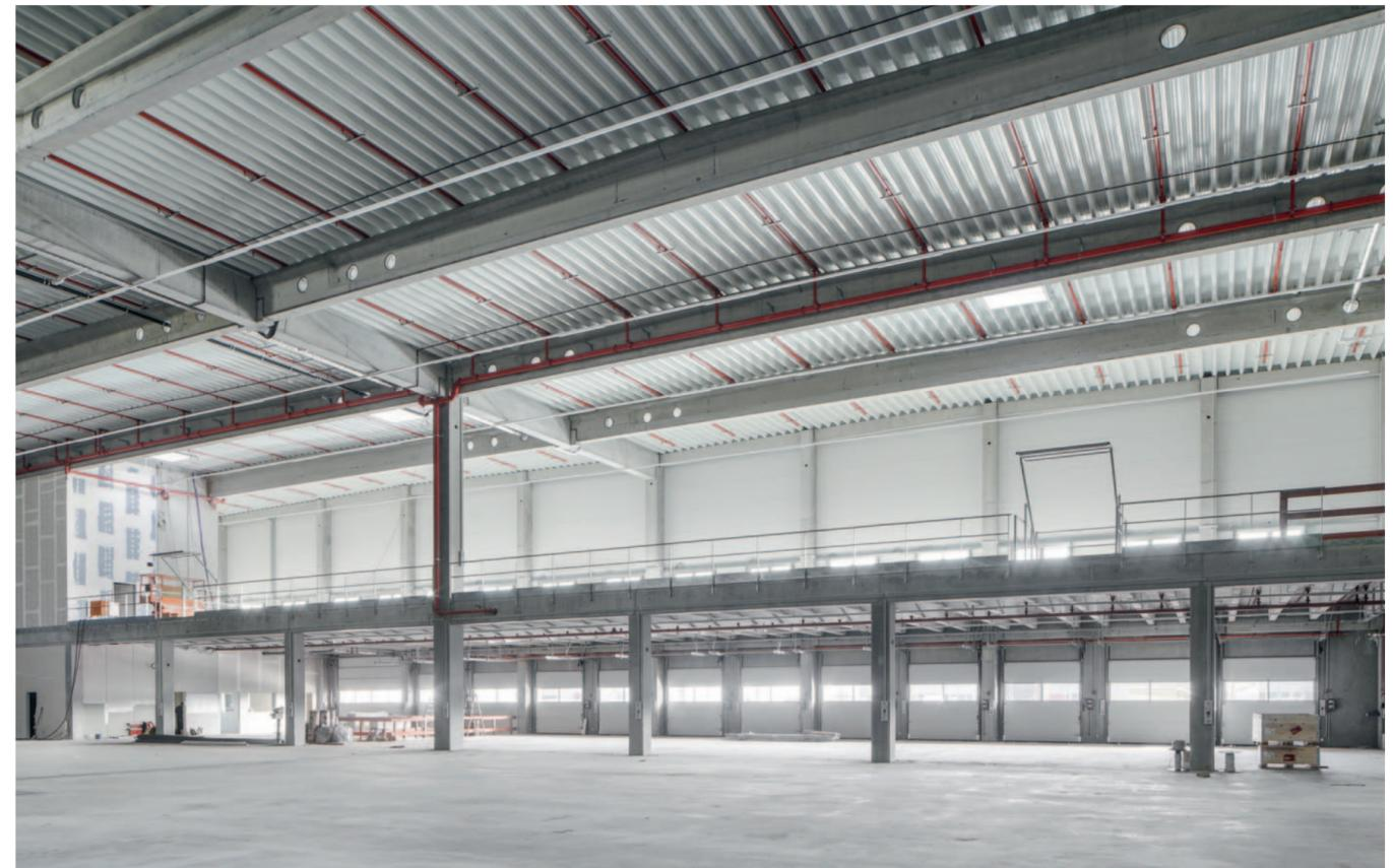
Die Fertigteilstützen mit angeformten Fundamenten sowie die Wände und Binder entstammen unserem Fertigteilwerk in Stockstadt am Main
