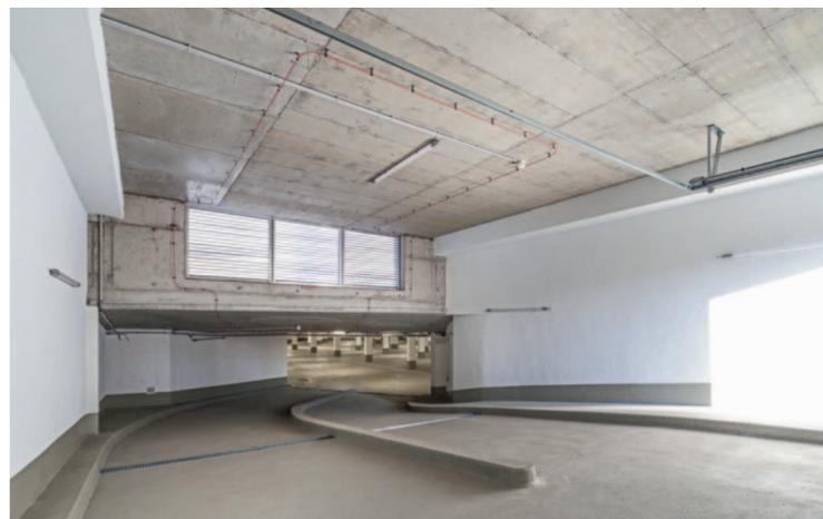
Höhenversprünge innerhalb der Tiefgaragendecke verlangten nach einer Lastabtragung über Konsolen und Unterzüge
