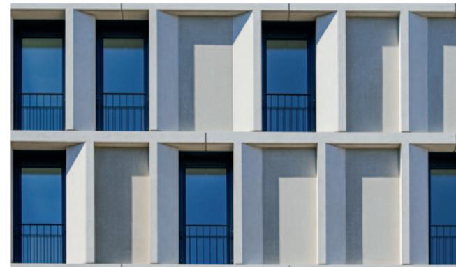
Der Wechsel von blinden und „sehenden“ Fenstern belebt die vorgehängte Architekturbetonfassade
