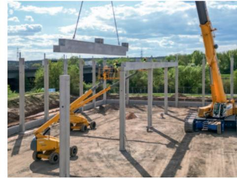
Montage der Betonfertigteilelemente
