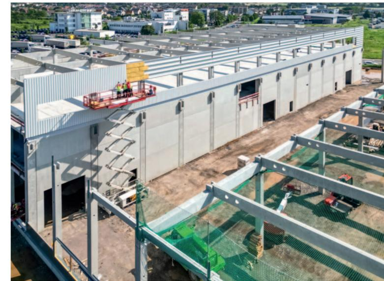
Passaden-Finish: Anbringen der äußeren Deckschale aus Trapezblech im Bereich der Kassettenfassade
