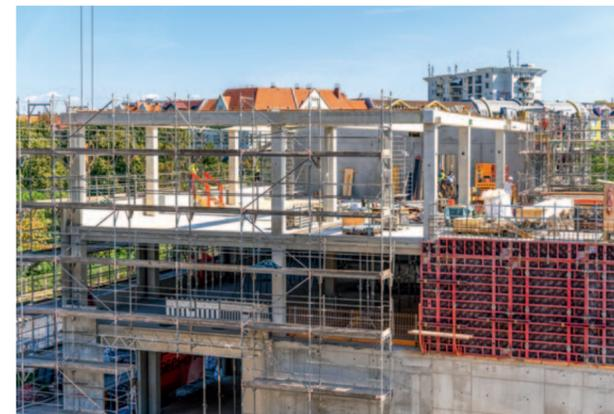
Die Montagearbeiten der Stahlbetonfertigteile am Bauteil 4, die von Dreßler Bau realisiert werden, schreiten zügig voran
